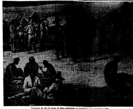
Primeiro da tela de Oscar da Silva, mostrando as rachaduras que ameaçam a obra.
