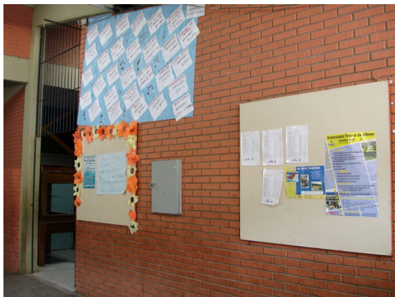
Figura 19 - Entrada para o setor administrativo
