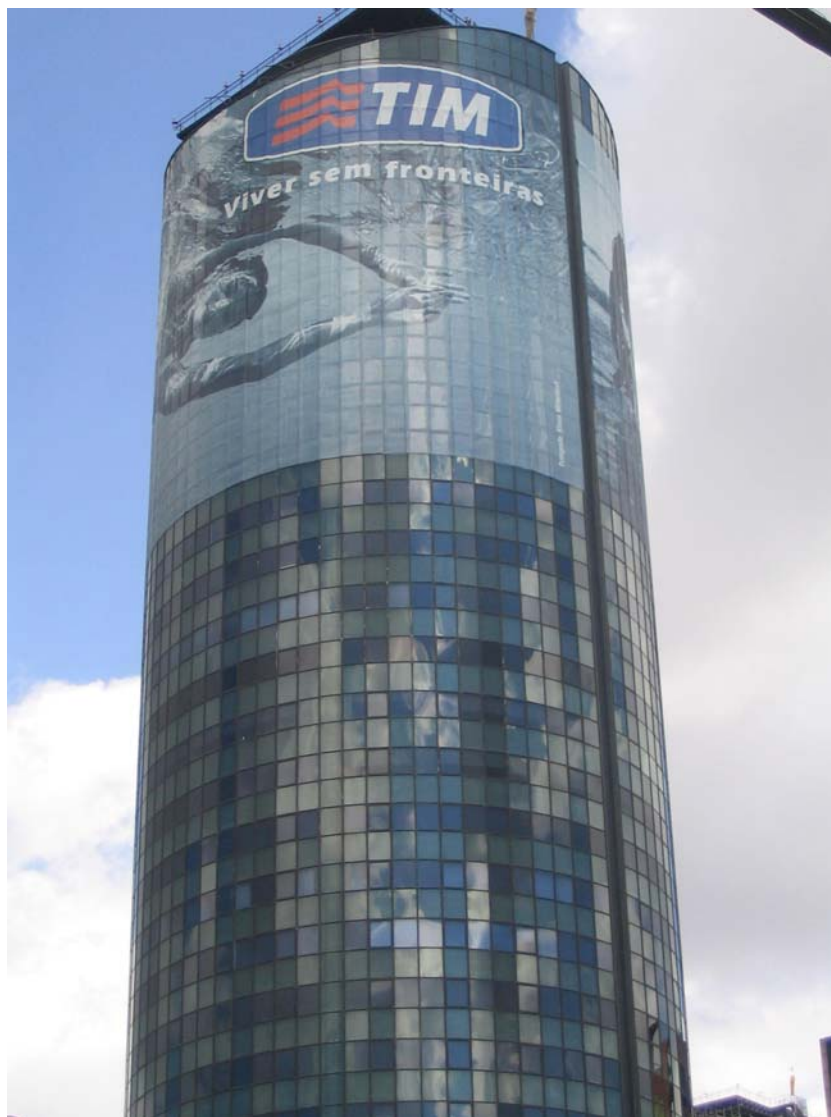
Figura 25 - Empena — Fonte: foto de PEREZ, A. Envelopamento do prédio da Dacon com a campanha da Tim Viver sem fronteiras . Avenida Faria Lima, São Paulo, em janeiro de 2005.
