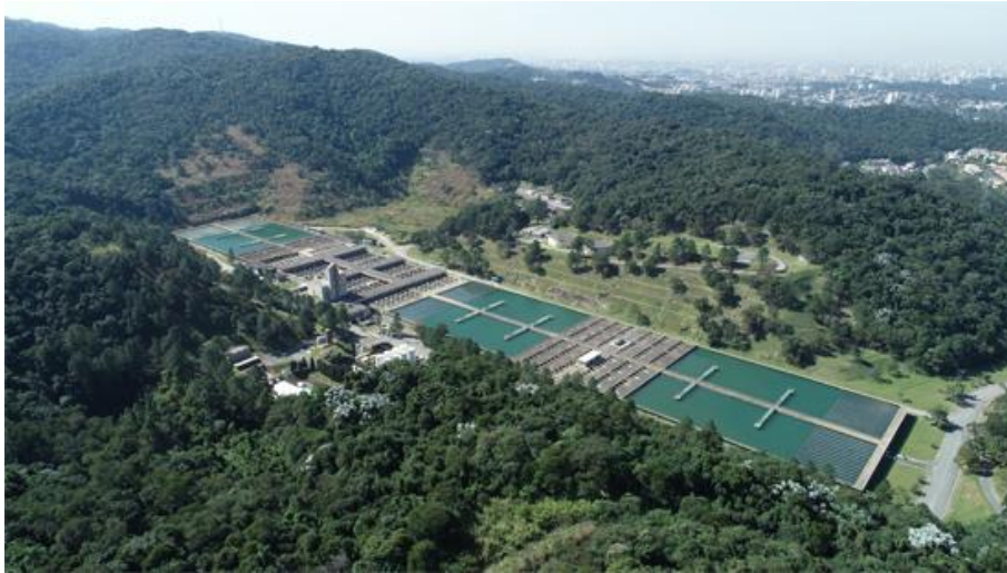
Figura 7 – Sistema de tratamento de água Guaraú.
