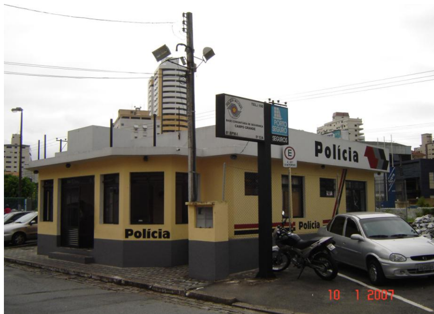
Figura 10 – BCS - Piloto “Campo Grande”, Rua Marques de São Vicente - Santos - antes da padronização visual Fonte: PMESP/DPCDH
