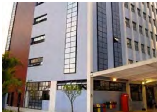
Figura 07 – Prédio Vila Mariana
