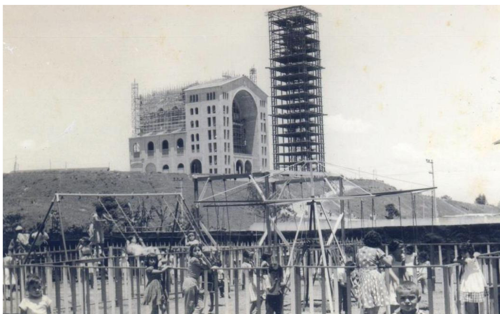
Figura 37 – Torre em construção.
