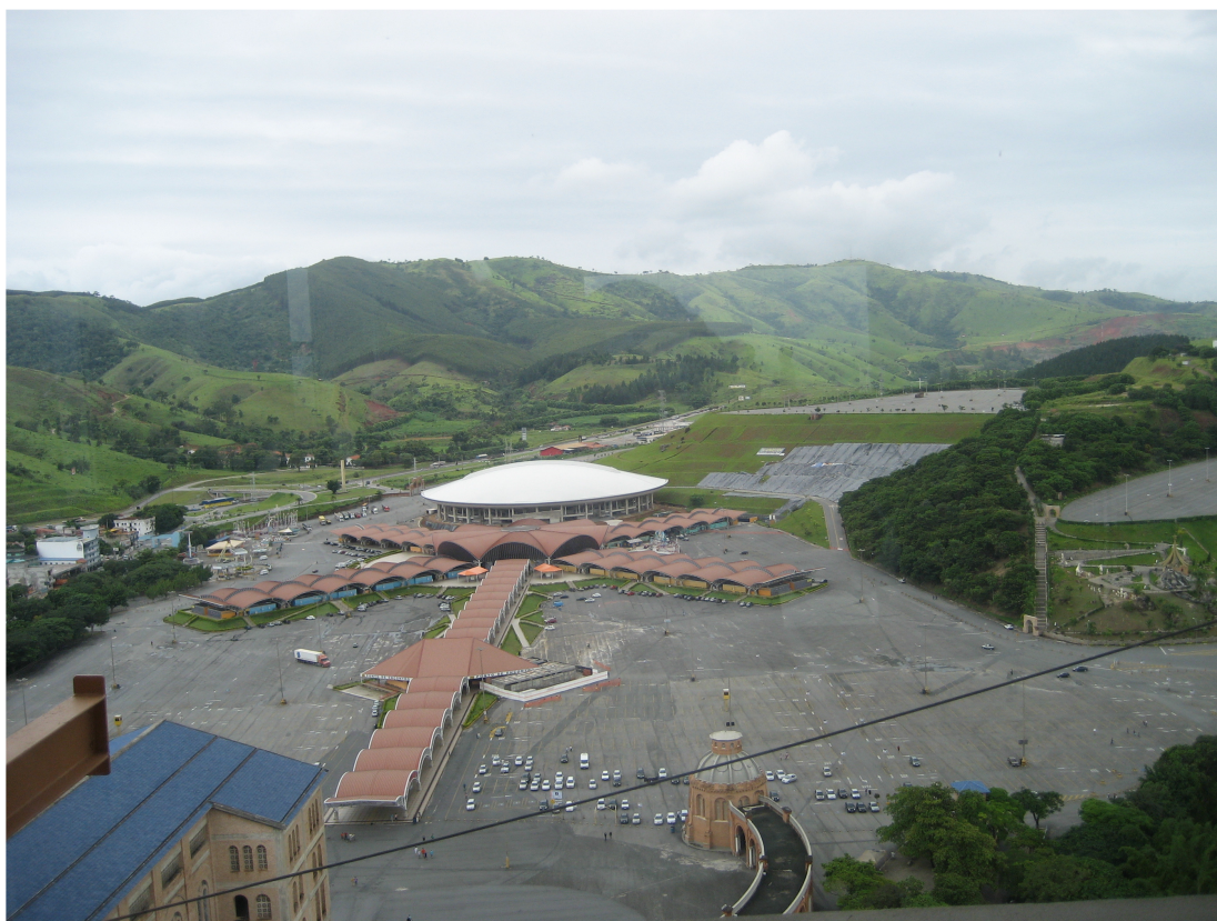
Figura 21 – Estrutura do Centro de Apoio ao Romeiro 80 .
