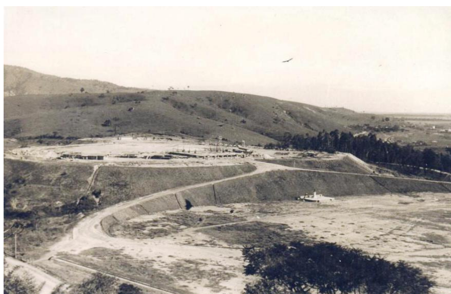
Figura 35 – Morro das Pitas – Serviço de Terraplanagem.
