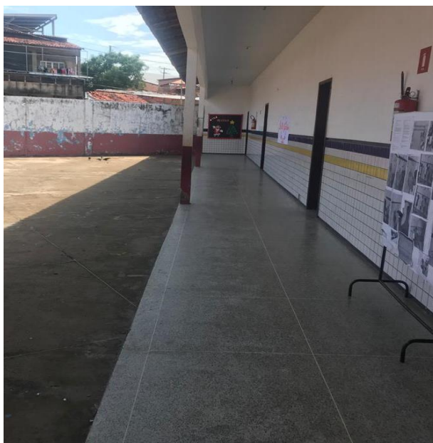
Figura 1 - Corredor de acesso às salas
