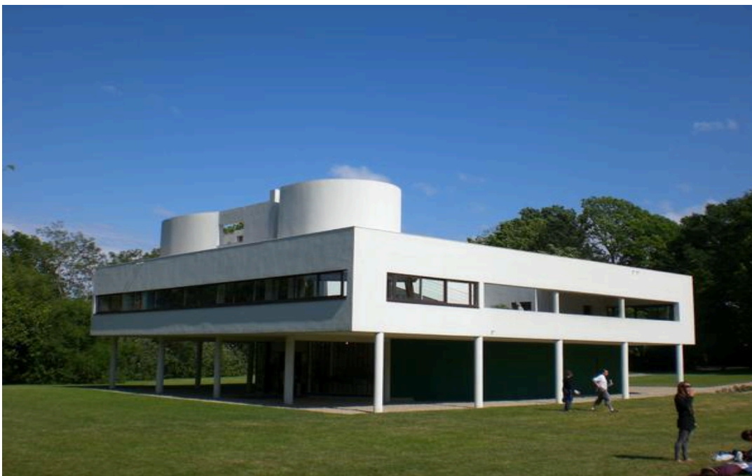
Arquitetura moderna de Le Corbusier. Foto: http://arquitetofala.blogspot.com.br/
