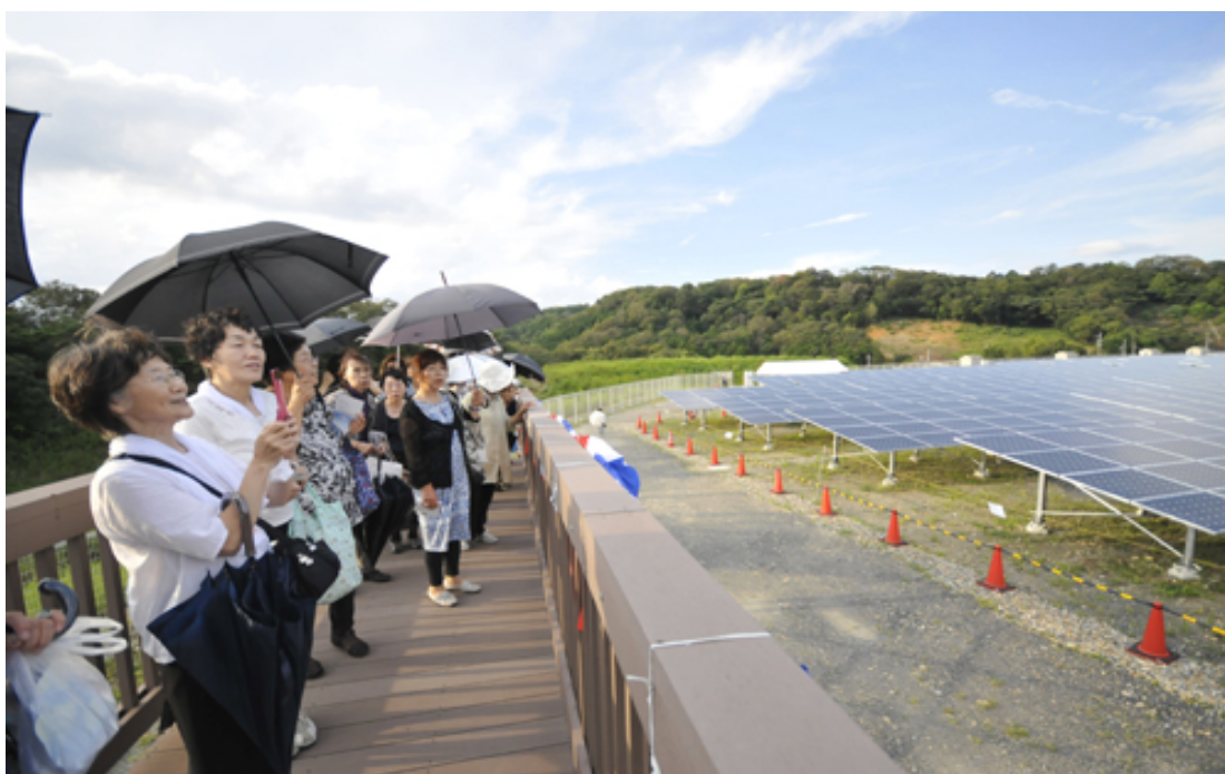
Painéis de energia solar construídos pelas SNI no Japão. Foto: http://www.sni.org.br
