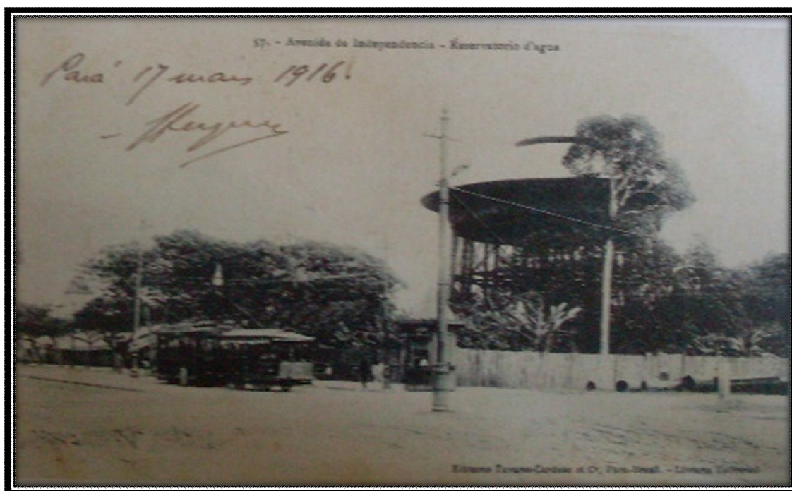
Figura 22 Reservatório d'água em ferro, localizado na Avenida da Independência 307
